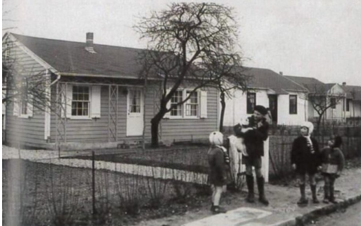
Avec des constructions rapides et efficaces après les bombardements de la Seconde Guerre mondiale, la cité expérimentale de Merlan a été bâtie entre 1945 et 1952 à Noisy-le-Sec par le ministère de la Reconstruction et de l'Urbanisme. DR
